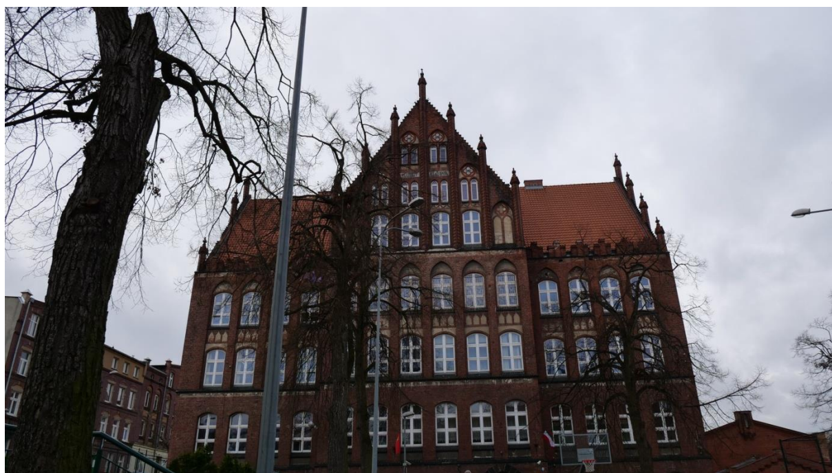
Elewacja frontowa (wschodnia) budynku głównego
