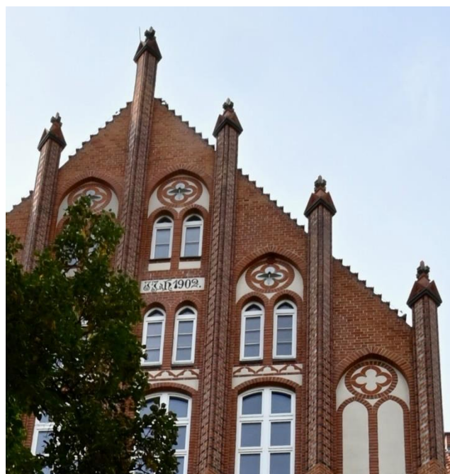
Cegły zdobiące elewację – częściowo kolorowe i profilowane
