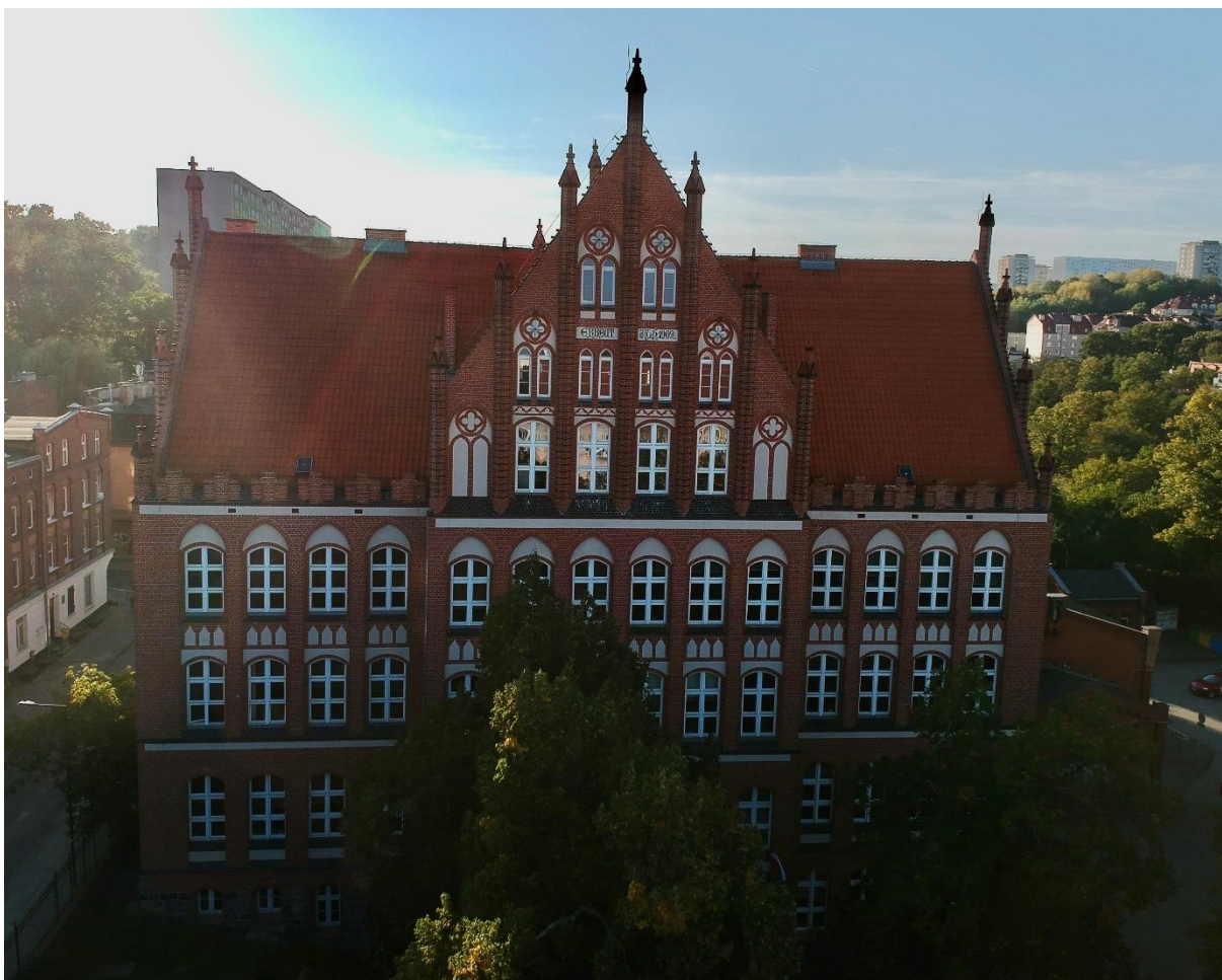
Elewacja wschodnia po remoncie zakończonym w 2021 roku
