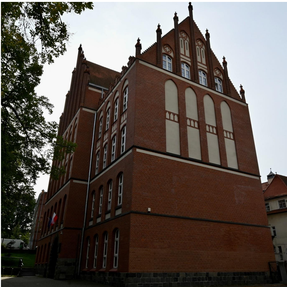
Elewacja wschodnia i boczna, widok z północnego zachodu
