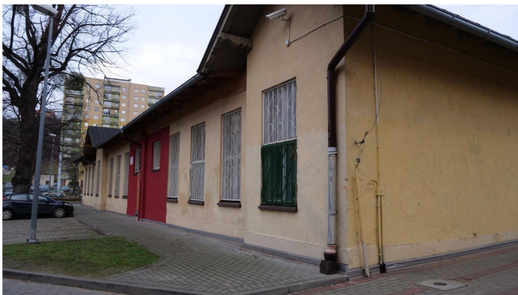
Pawilon – elewacja zachodnia (od strony parkingu)
